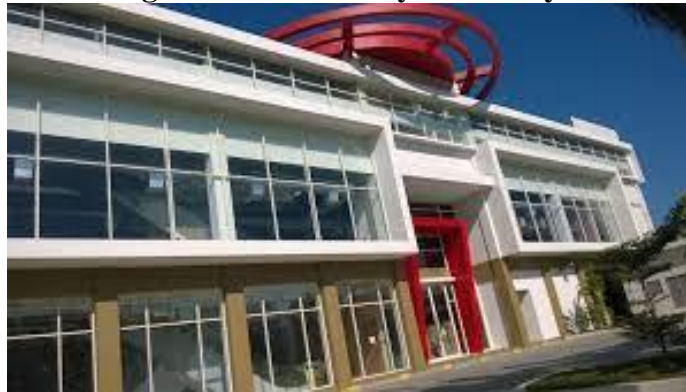
Gambar 1 Foto Bangunan PT. Bumi Nyiur Swalayan Pusat.
